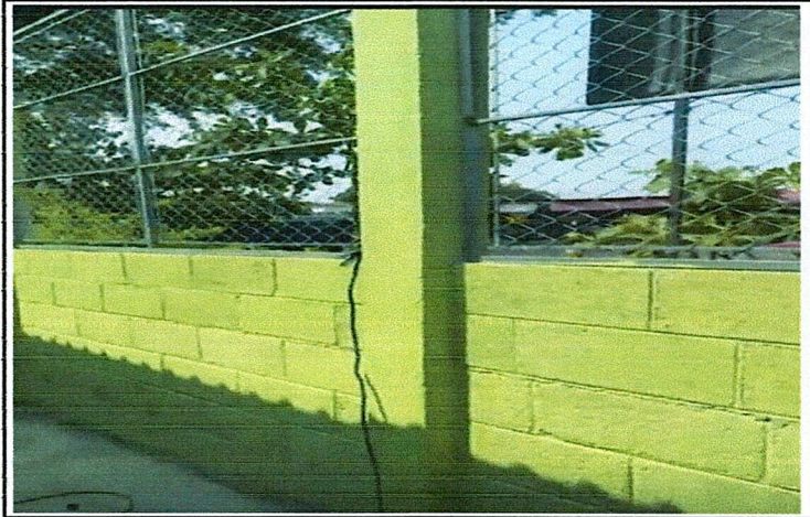
Foto 2: Mejoramiento Muro perimetral
