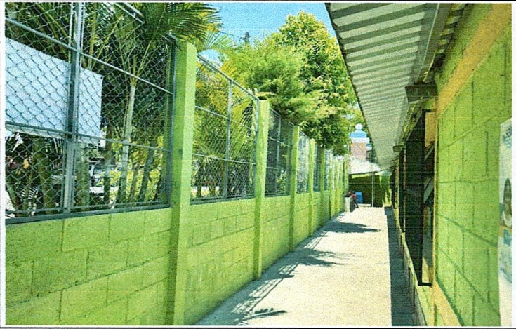
Foto1: Mejoramiento de Muro perimetral
