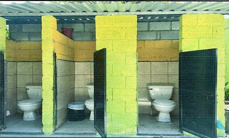
Foto 3: Mejoramiento de baños, piso, techo, azulejo
