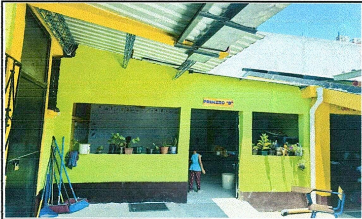
Foto 4: Mejoramiento techo tipo portico
